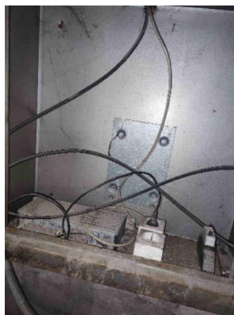
üzemképtelen elektromos elosztó
